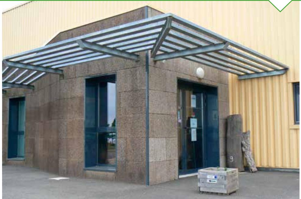
*La maison Zen (Zero Energie Net) construite par le bureau d'étude énergétique Cythélia est construite en CLT (KLH), puis isolée par l'extérieur par 150 mm de liège. Un bardage vient habiller la façade.*
