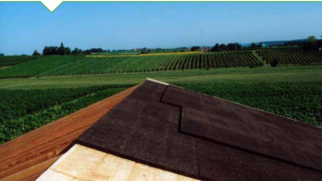
*En sarking ou par l'intérieur, le liège convient parfaitement pour l'isolation des toitures. Il peut être rainuré ou non. Chez Snic, les épaisseurs varient de 20 à 200 mm, son lambda est de 0,040 W/m.K (ACERMI).*
