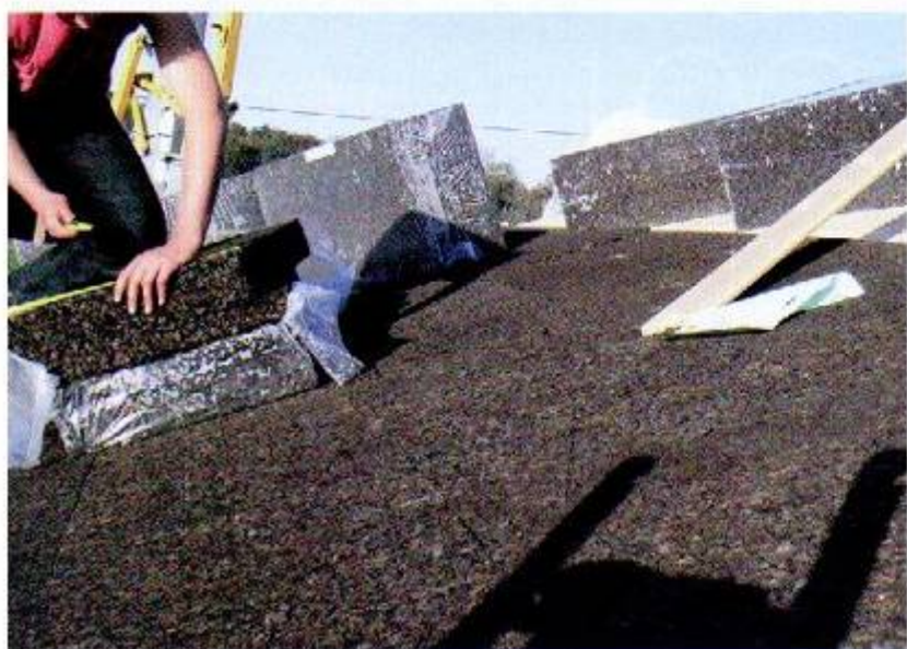
Les plaques de liège (1 m x 0,5) sont clouées ou visées soit sur le solivage, soit sur ou entre les chevrons.
